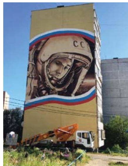
Фасад жилого дома в Подмосковье, утеплённый и декорированный ТСМ Керамик
