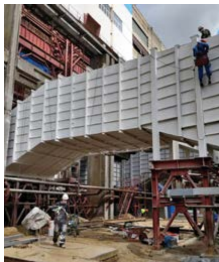
Нанесение покрытия ТСМ Керамик на объекте «Мосэнерго»
